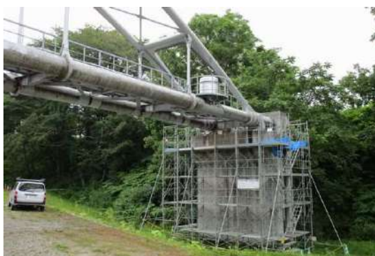
札内川水管橋耐震補強工事
