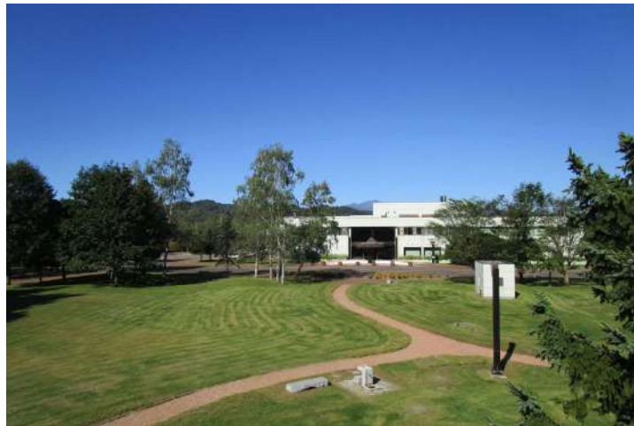
なかとかち浄水場
