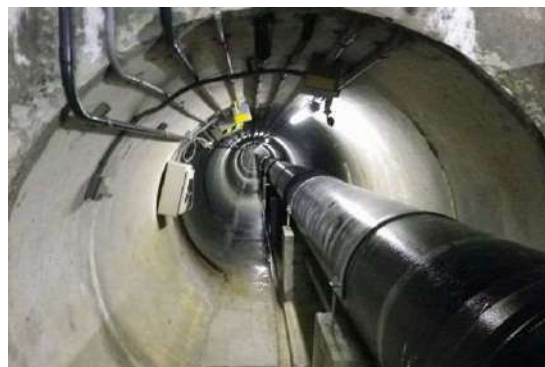
十勝川横断施設（内部）
