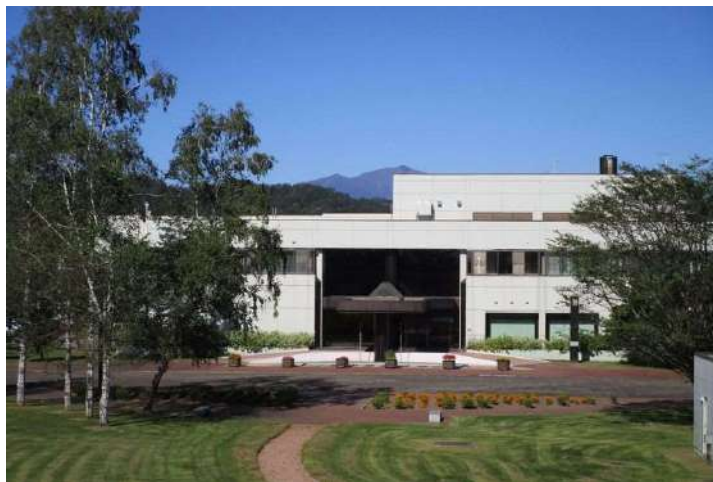
なかとかち浄水場
