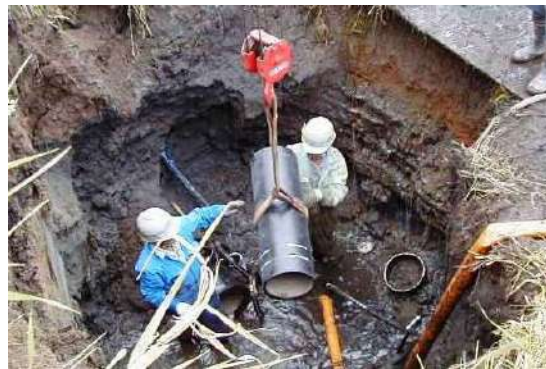
平成 15 年十勝沖地震復旧工事（池田町）
