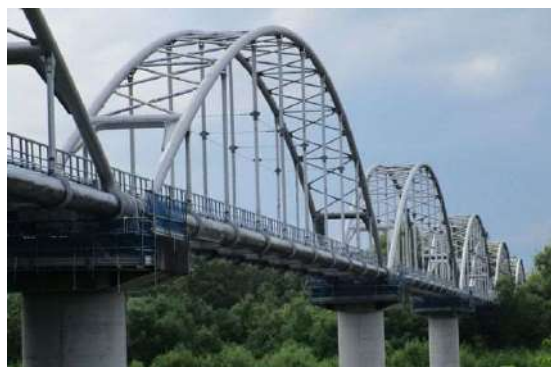
札内川水管橋
