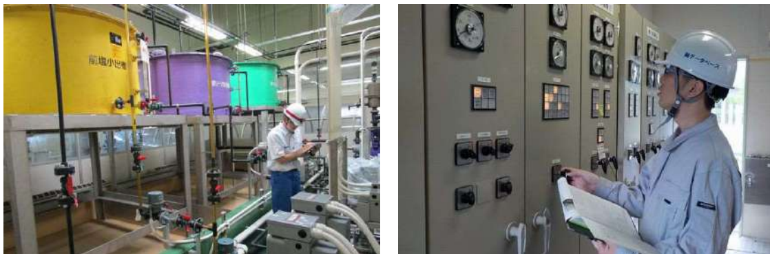
日常点検の様子
